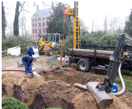
Werkzaamheden voor het slaan van de bron in volle gang
