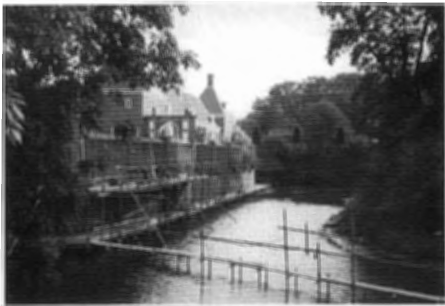
Restauratie aan de muren boven de gracht. Foto Megteld Leenknecht.
