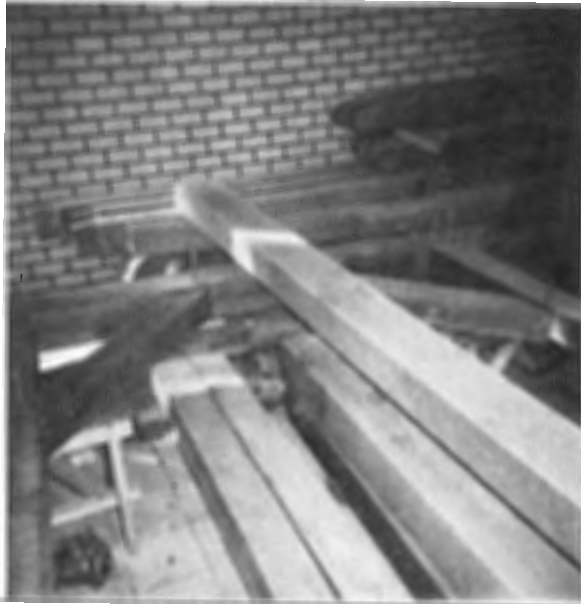
De constructie van de zandvinken
