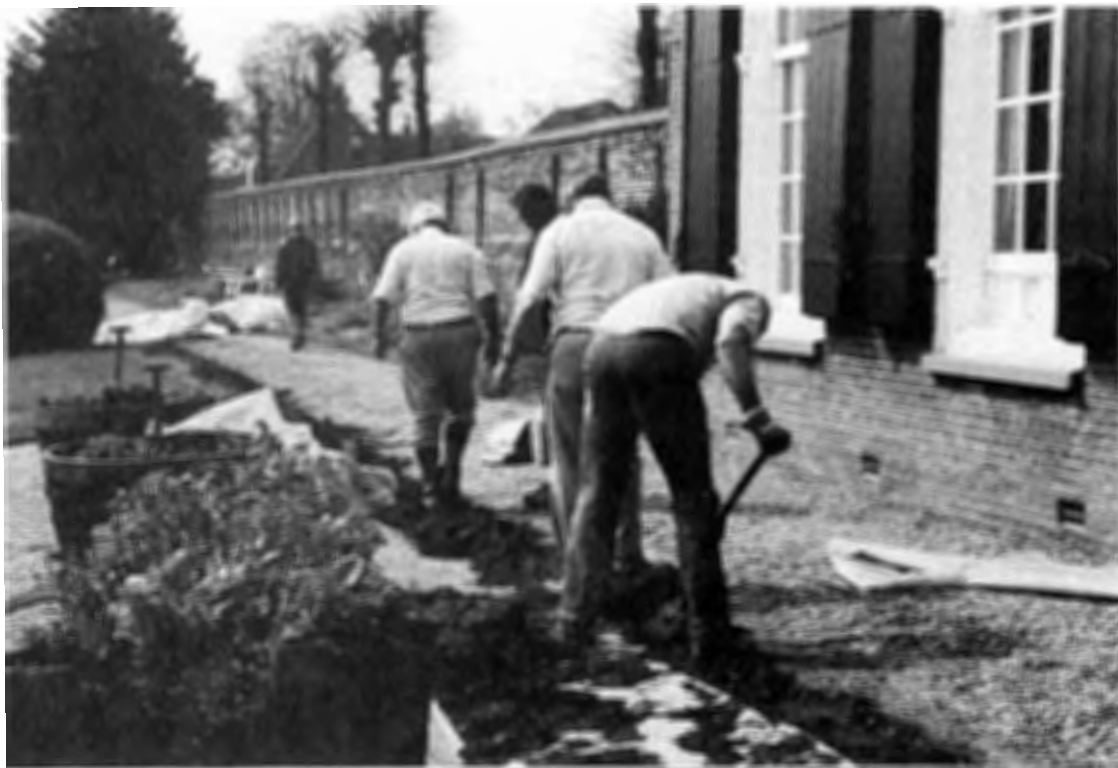
Aanleg van een regeninstallatie in de tuin van Kasteel Amerongen 21 april 1990 - Het leggen van leidingen en het graven van geulen daarvoor ...
